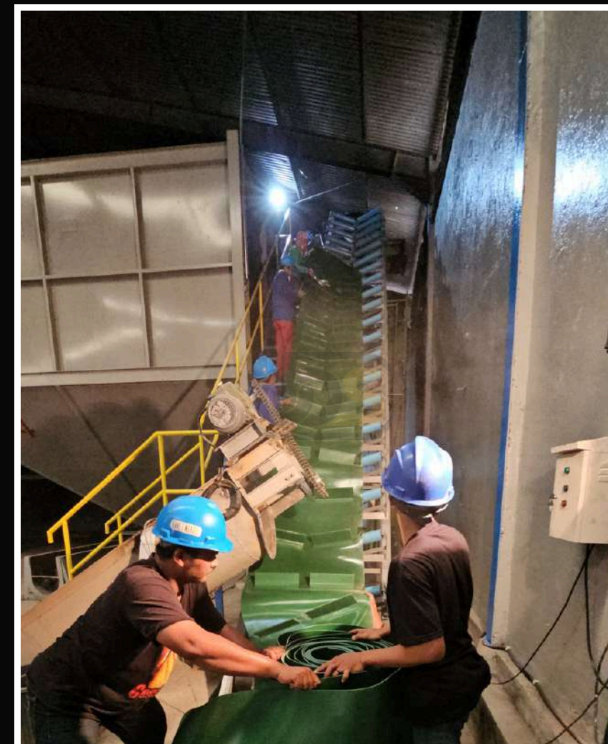
INSTALASI CONVEYOR BELT PADA CONVEYOR UNIT
